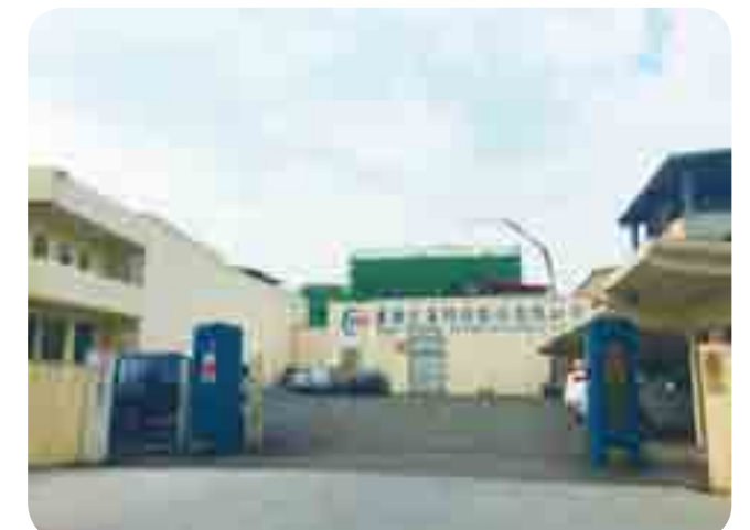
東典光電科技股份有限公司廠區圖
