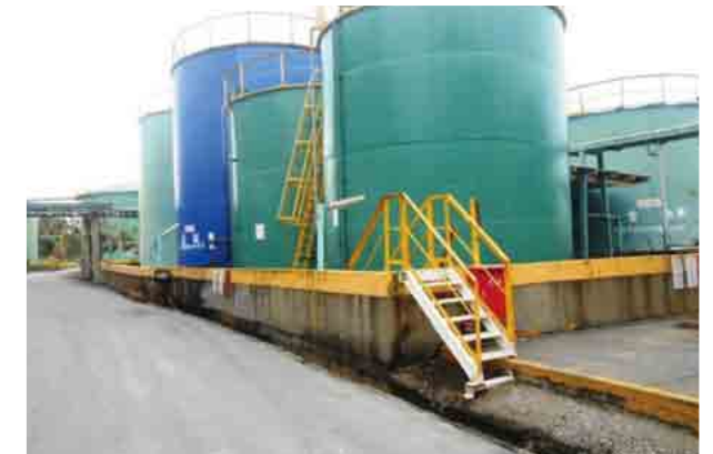
化學物質儲槽區設置防溢堤
